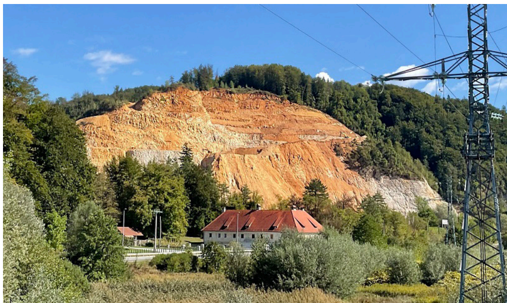
Slika 3: Čelo kamnoloma Lukovica: eksploatacija in sprotna sanacija
