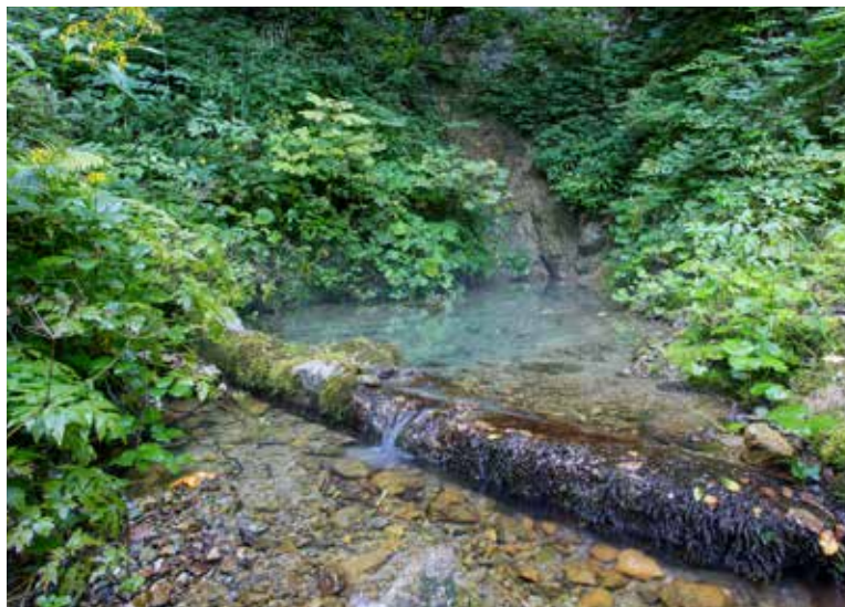
Betonski prag pod izvirom
