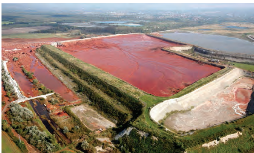
Slika 2: Porušitev zadrževalnika v Ajki (vir: Ajka accident, http://commons.wikimedia.org/wiki/File:Ajka_accident_7b9017f332_b.jpg )
